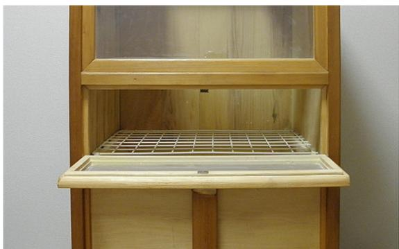
5. 開閉の扉を開けた状態。開口上部中央に磁石、扉には金具を取り付けている。
